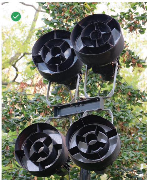
Světelné znečištění způsobené světlomety lze snadno omezit technickými doplňky
